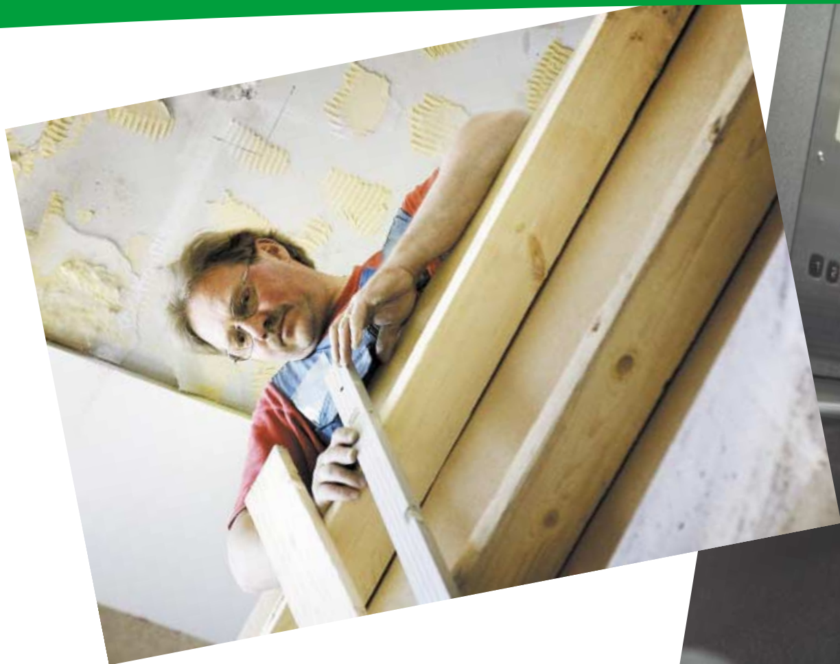
YIT:n Matti Pesonen ottaa mittoja hissikuilussa Vanhan Vaasan katu 38:ssa, johon valmistuu uudet hissit ensi vuoden alkupuolella.
