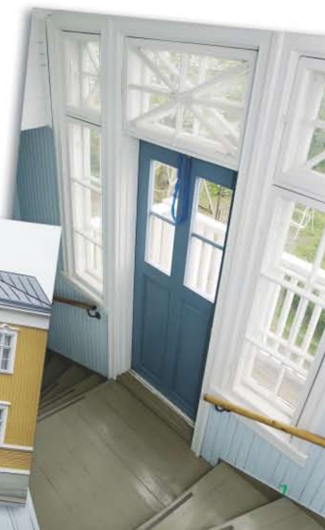
Vöyrinkatu 11:ssä säilytettiin talon hirsirunko ja huoneistopohja. Talosta löytyy oma ullakko, niin kuin mummoloissa kuuluukin. På Vörågatan 11 har man bevarat husets stockstomme och lägenhetsindelningen. Huset har egen vindsvåning precis som det skall vara i en mormorsstuga.
